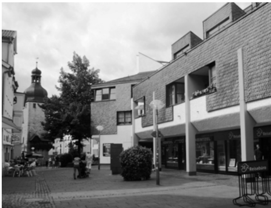
2. Budynek usługowo mieszkaniowy w Coburgu, Niemcy. Fot. J.M. Chmielewski
