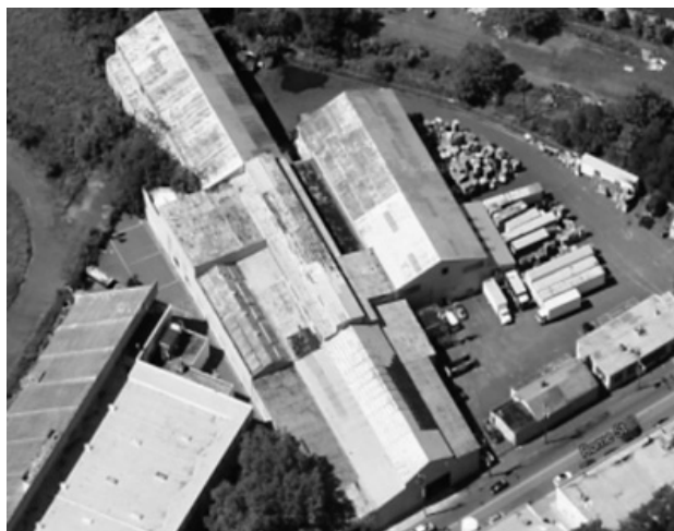
Rys. 8. Nieczynna stalownia w dystrykcie Ironbound, Newark, adaptowana na farmę wertykalną
